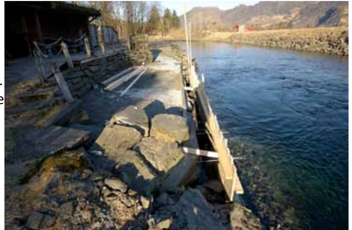
Forskaling er på plass foran plattformen i sone 10.
